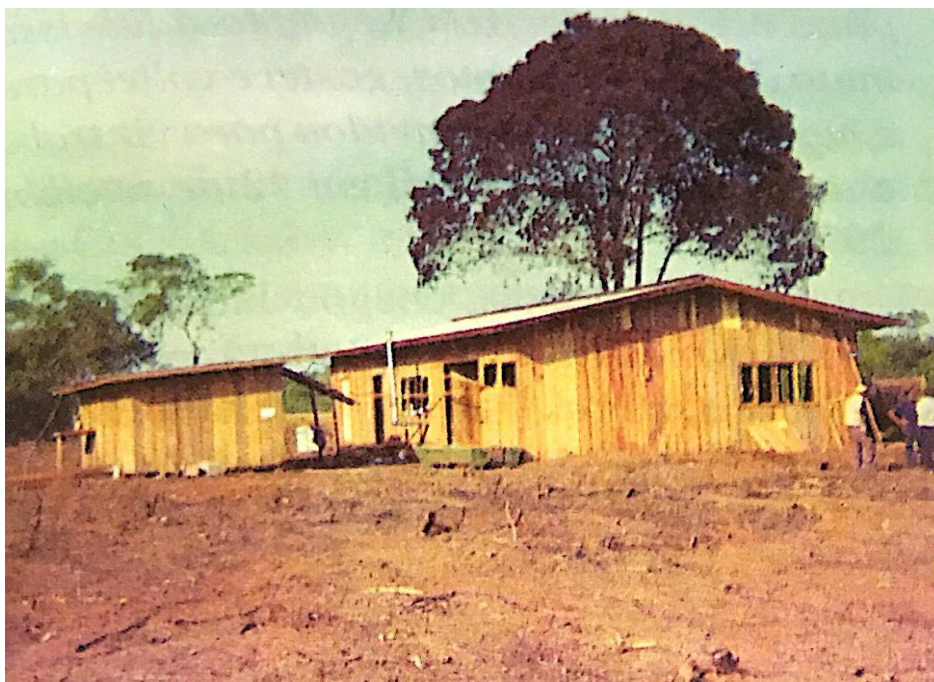
Figura 3: Sorriso (MT): Local onde foi construída a primeira casa na década 1970.
