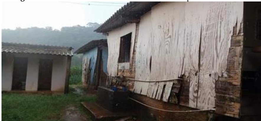
Imagem 2. Escola Itinerante Valmir Mota de Oliveira – pátio dos banheiros
