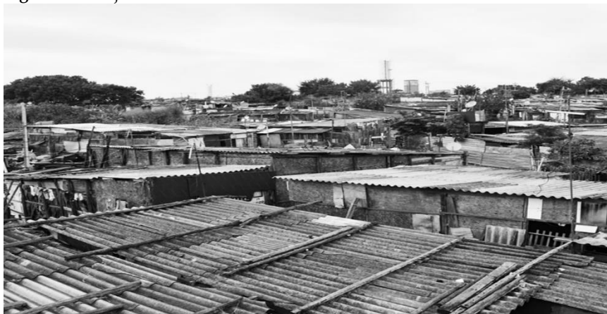
Figura 3 – Conjunto de barracos na Favela
