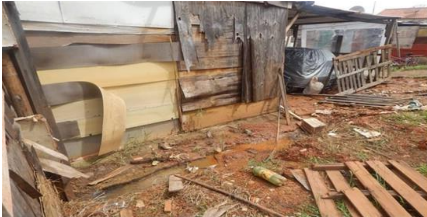
Figura 2 – Barraco na Favela Zumbi dos Palmares, material frágil na construção das moradias
