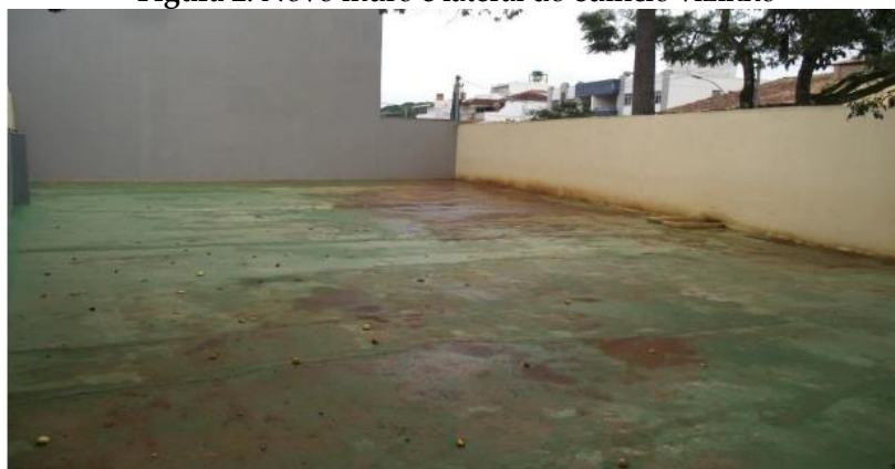
Figura 2: Novo muro e lateral do edifício vizinho
